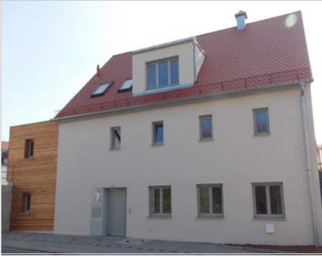
Pfarrhaus, barrierefreier Zugang ins Pfarramt am Amselweg;
